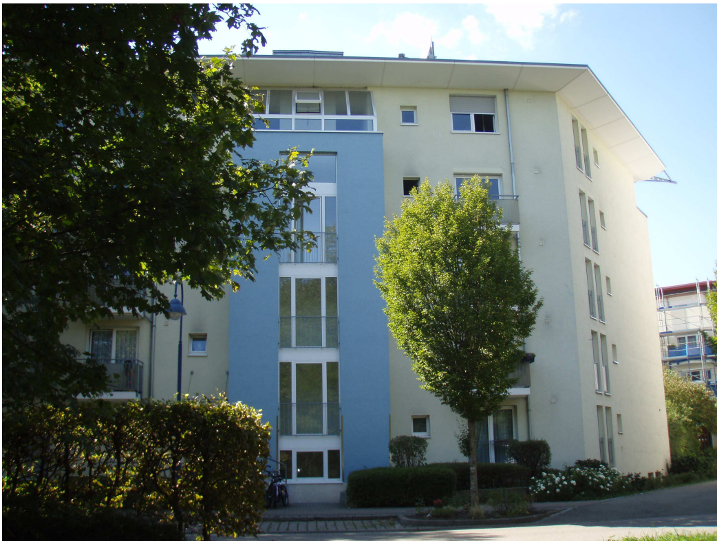
Ansicht des Gebäudes von der Straßenseite aus betrachtet
